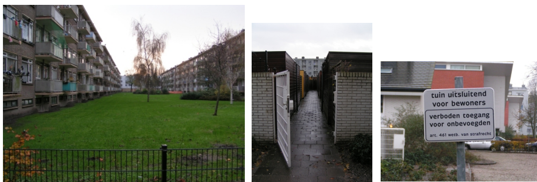
Figuur 6.1 Beschikbare gegevensbestanden maken het niet mogelijk om alle ontwikkelingen t.a.v. groen in de stad te volgen. Een collectieve tuin bij hoogbouw die bij herstructurering wordt opgedeeld in privétuinen bij eengezinswoningen is daarvan een voorbeeld.
