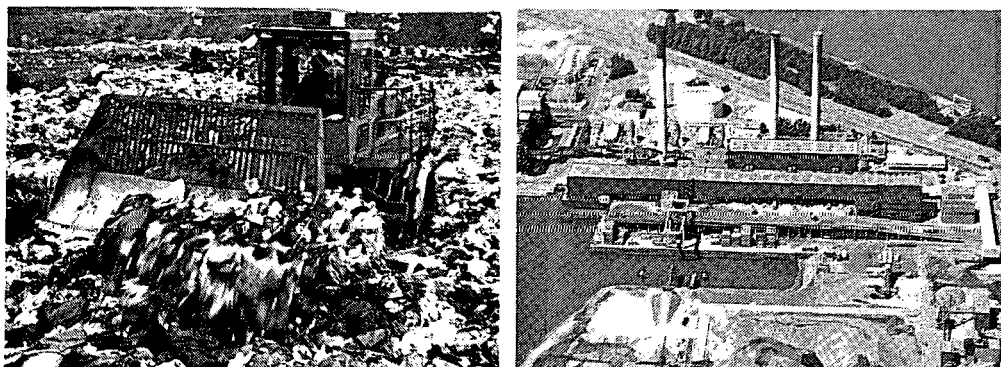
Fig. 3 Stortplaats voor afval (links) en een installatie voor vuilverbranding (rechts)
